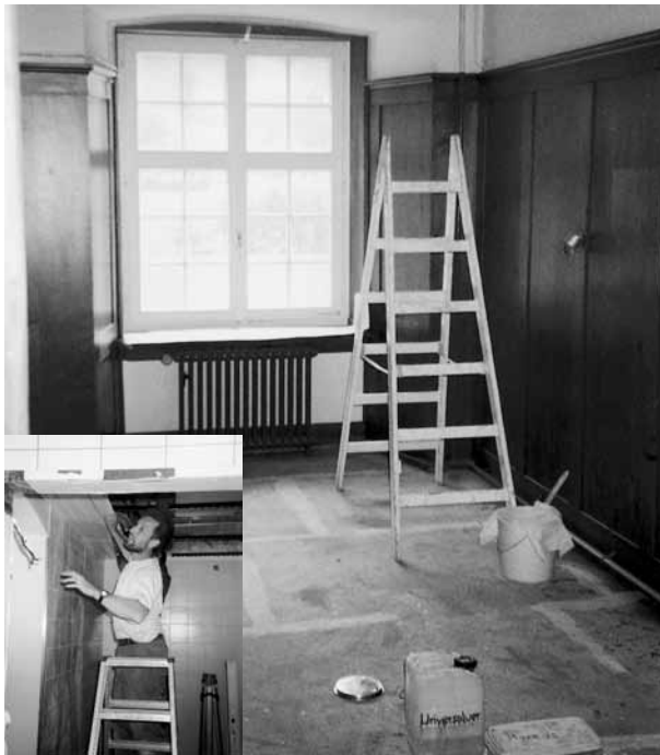
Bauarbeiten am neuen Internat Klosterhof.
